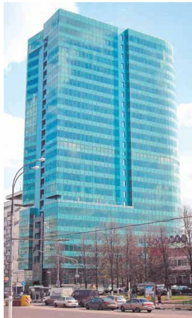
Бизнес центр «Газойл плаза» Москва, ул. Наметкина, 14
